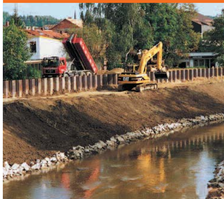
Hochwasserschutzwand mit Stahlspundwand im Bau
