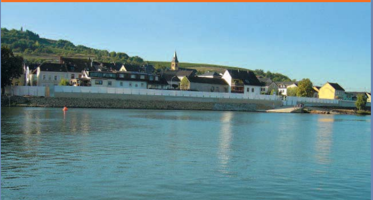
Hochwasserschutz in Oberbillig an der Mosel
