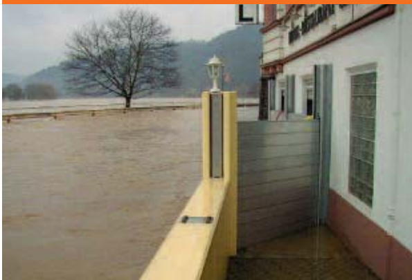
Umlaufender Hochwasserschutz mit teilmobilen Schutzelementen
