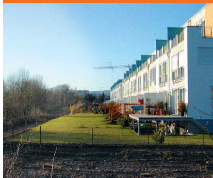
Hochwasser angepasste Bauweise mit erhöhtem Erdgeschossniveau
