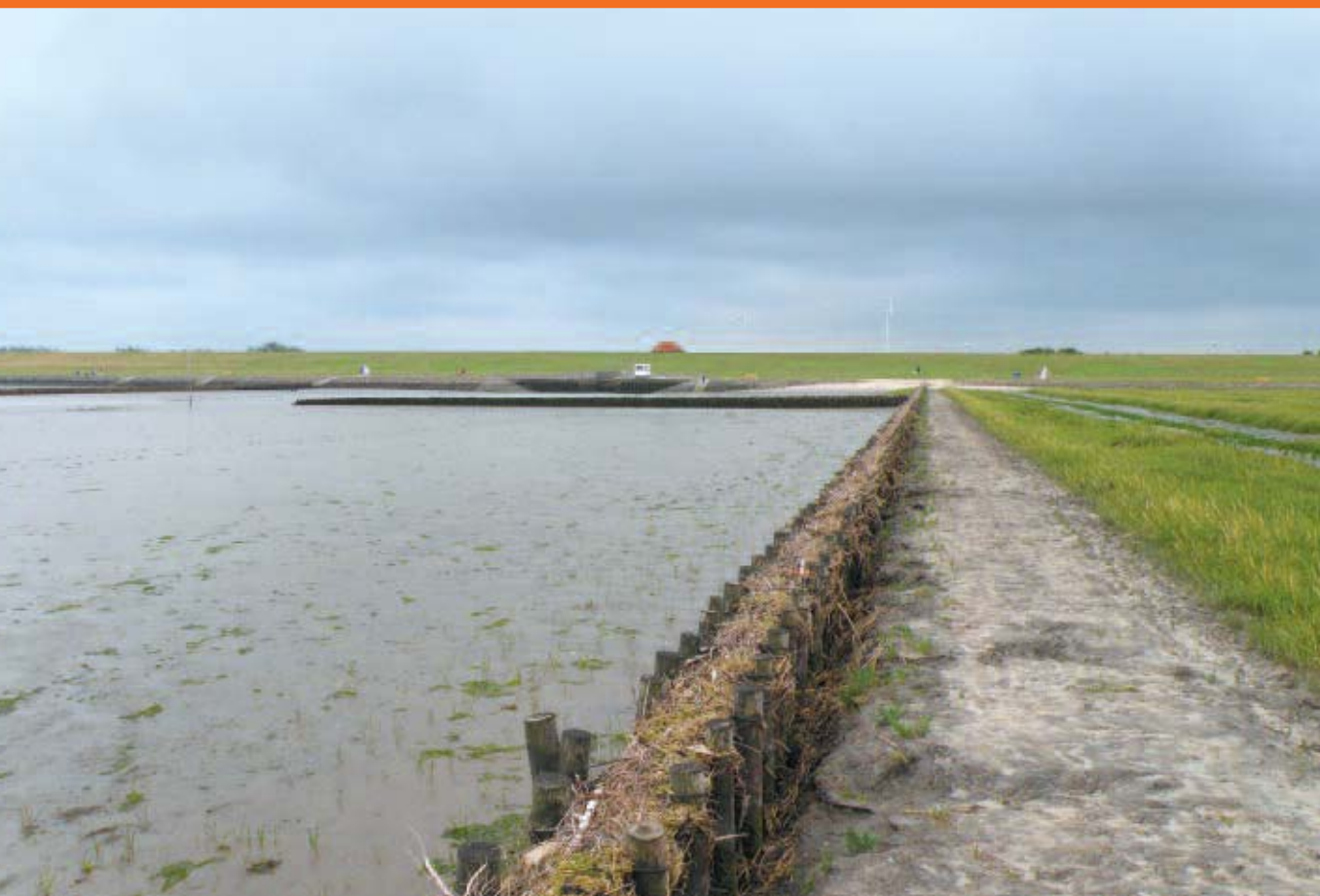
Küstenschutz mit Lahnungen und Hochwasserschutzdeich
