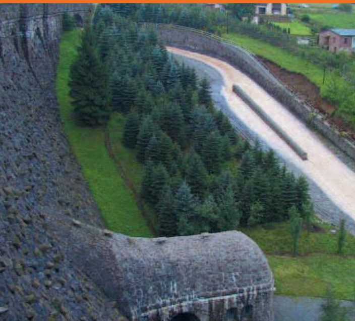
Talsperre mit Hochwasserentlastung
