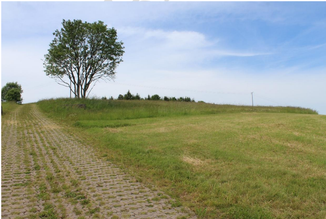
Abbildung 2: Blick Richtung Westen hangaufwärts vom Bestandsweg mit den beiden Salweiden
